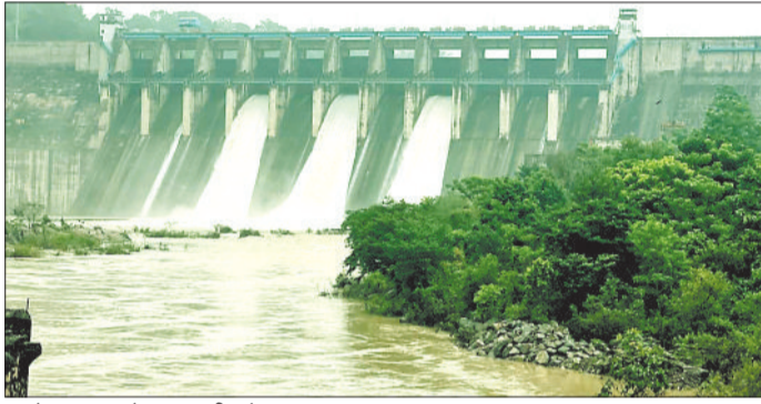
बांगो बांध का खोला गया तीन गेट।
